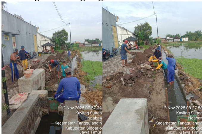
Gambar 2. Pembangunan Plengsengan di RT 13
