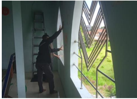
Gambar 9. Perbaikan Jendela & Pintu
