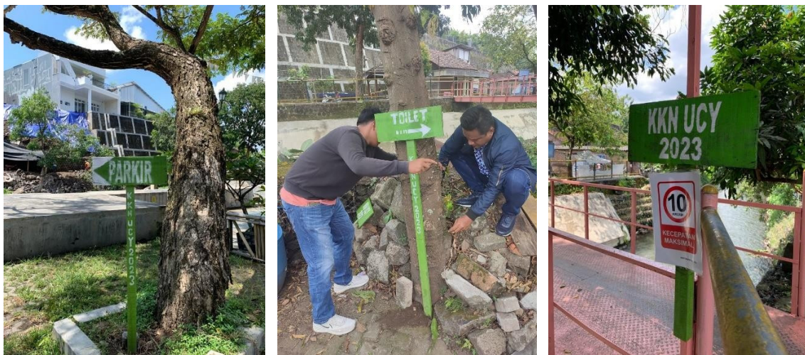
Gambar 3. Perawatan Jembatan dan Pemasangan Papan Petunjuk
