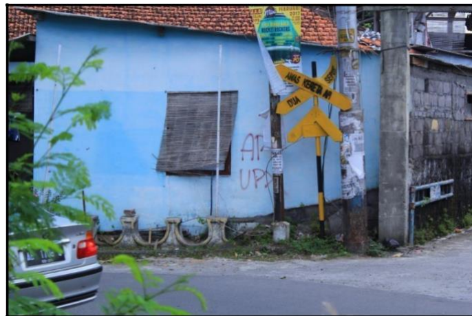
Gambar 6 Rambu peringatan perlintasan sebidang Double Track pada sisi utara perlintasan
