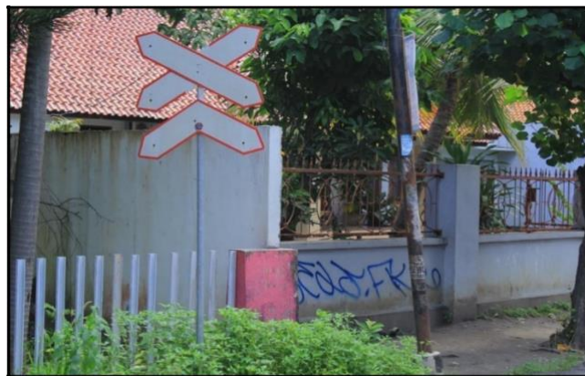
Gambar 4 Rambu peringatan perlintasan sebidang Double Track sisi selatan perlintasan
